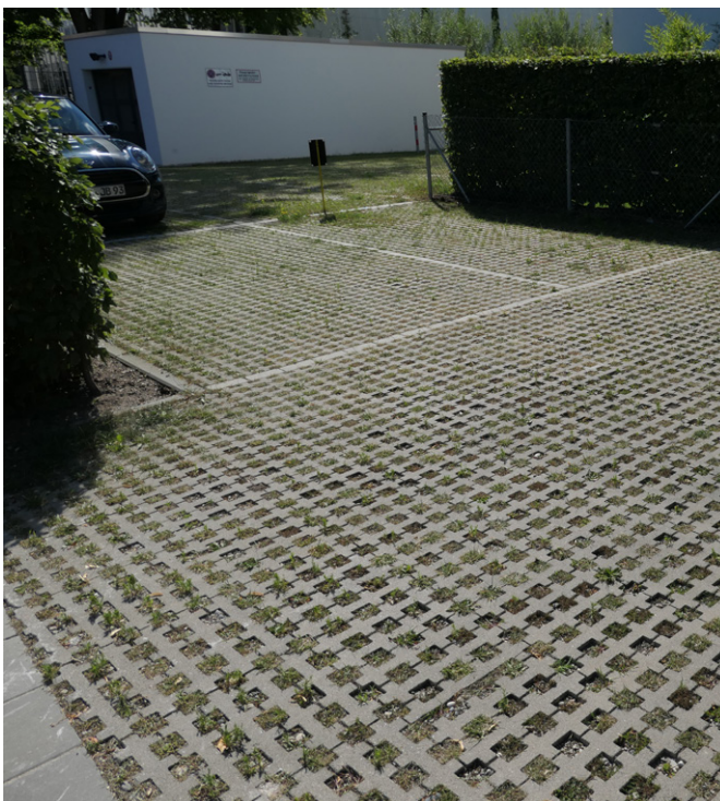
Abb. 43: Teilentsiegelung eines Parkplatzes, Freising
