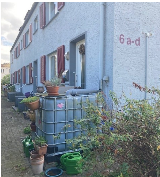
Abb. 60: Zisternen an Wohnhäusern, Weil am Rhein
