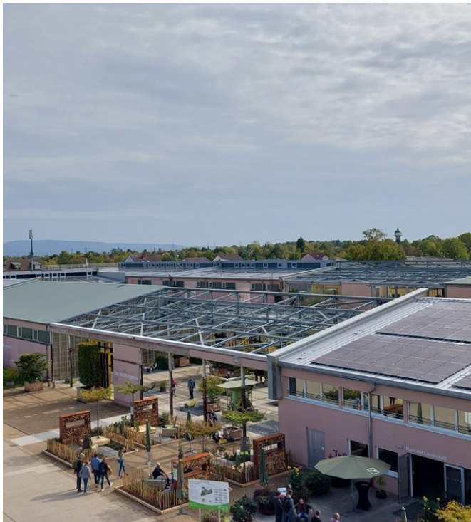
Abb. 38: Teilabbruch Gebäude zugunsten Kaltluftströmung, Mannheim
