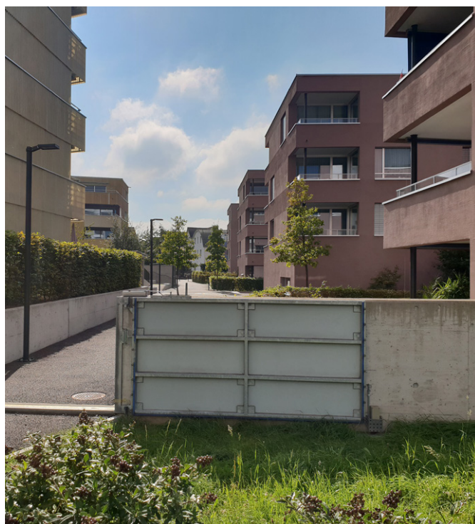
Abb. 61: Baulicher Überflutungsschutz Wohnhäuser, Zürich
