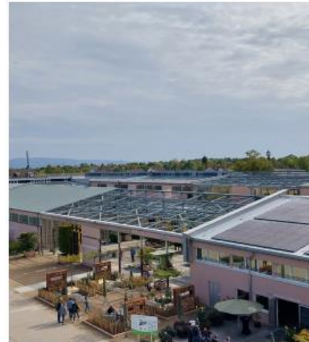
Abb. 43: Teilabbruch Gebäude zugunsten Kaltluftströmung, Mannheim
